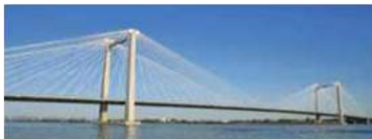
Мост на тросах
