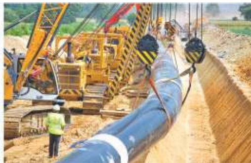
Мал. 70. Укладка газавода
