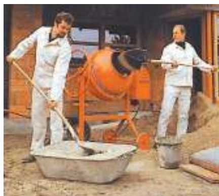
Мал. 92. Прыгатаванне бетону — суспензіі пяску і цэменту ў вадзе
