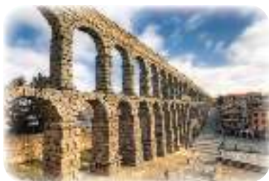
el acueducto de ...
