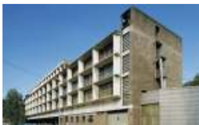
Usine Claude-et-Duval à Saint- Dié-des-Vosges, France.
