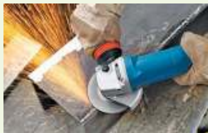
Шлифование металла угловой шлифовальной машинкой
