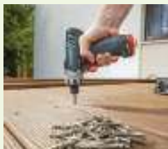
Ввинчивание шурупов
