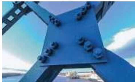
Рис. 88. Примеры болтового соединения
