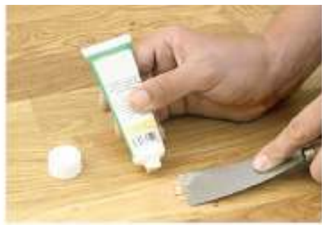
Нанесение шпатлевки
