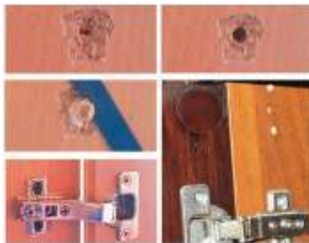
Рис. 131. Ремонт петель
