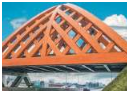
Рис. 4. Мост из модифицированной древесины в Нидерландах
