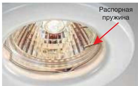
Рис. 120. Замена галогенной лампы
