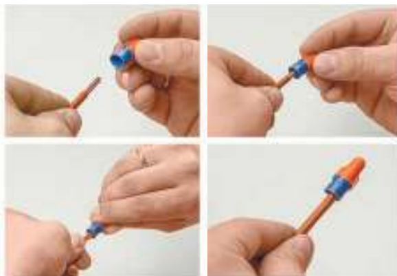
Рис. 115. Приемы соединения проводов колпачком СИЗ
