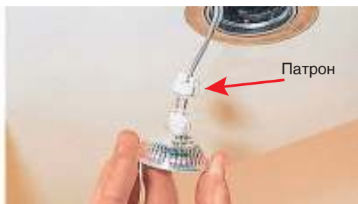
Рис. 120. Замена галогенной лампы
