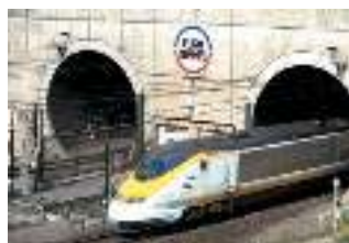
L'Eurotunnel sous la Manche
