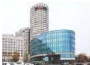
Рис. 162. Здание «Банк БелВЭБ», г. Минск
