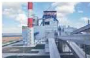
Рис. 149. Белорусский цементный завод, г. Костюковичи
