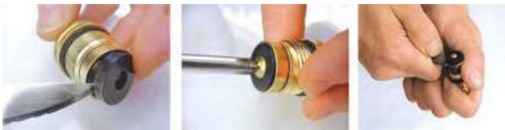
Рис. 109. Замена прокладки в кран-буксе
