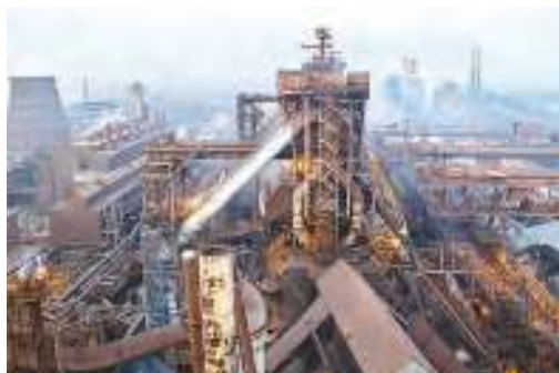
Общий вид доменной печи
