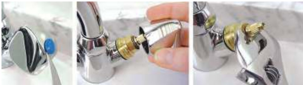
Рис. 108. Демонтаж кран-буксы
