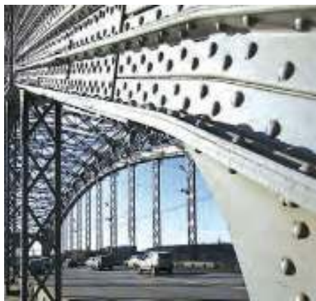
Рис. 70. Мост с соединениями конструкции на заклепках
