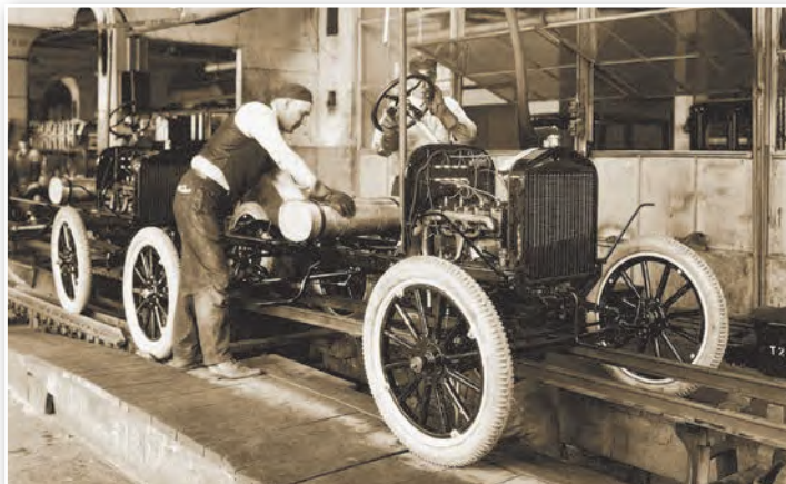
Канвеерная вытворчасць на заводзе Форда. У 1913 г. Г. Форд запусціў першы ў свеце аўтамабільны зборачны канвеер, што прывяло да павышэння эфектыўнасці вытворчасці
