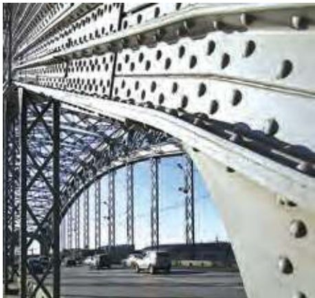
Мал. 70. Мост са злучэннямі канструкцыі на заклёпках
